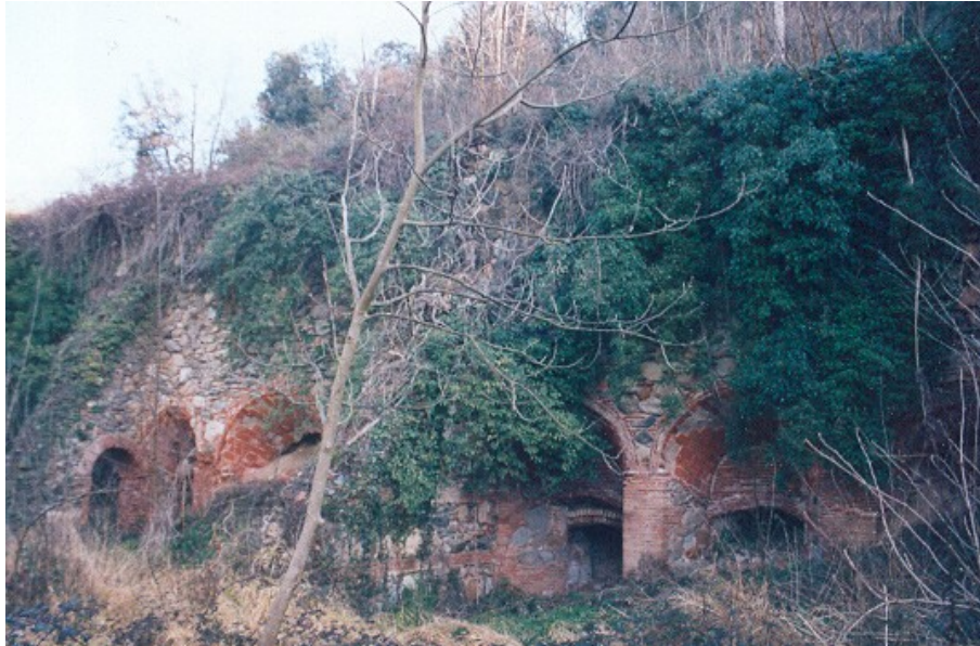
Figura. 3. Aspecte actual, dels primers forns verticals per a l'elaboració de ciment pòrtland de Catalunya, a Campins (Vallès Oriental).Arxiu Autor.
