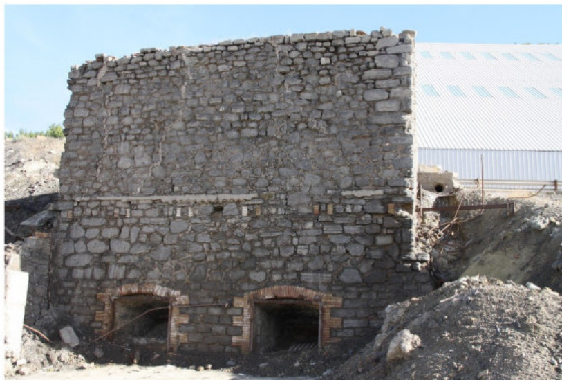
Figura 6. Recinto de la actual planta de tratamiento de sales potásicas de IBERPOTASH, S.A. Hornos de cal contruidos durante la construcción de la fábrica de tratamiento y del primer pozo minero o “Vell” de la cuenca potásica catalana. Archivo Autor.
