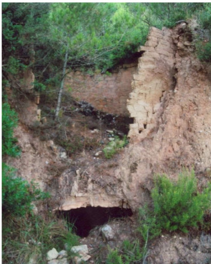
Figura 3. Marganell (Forn de La Calcina). Horno de cal del tipo tradicional, del que las paredes internas del hogar del horno se han derrumbado. En la parte inferior, se aprecia claramente la abertura destinada a la colocación del combustible (leña de pino o encinar). Archivo Autor.
