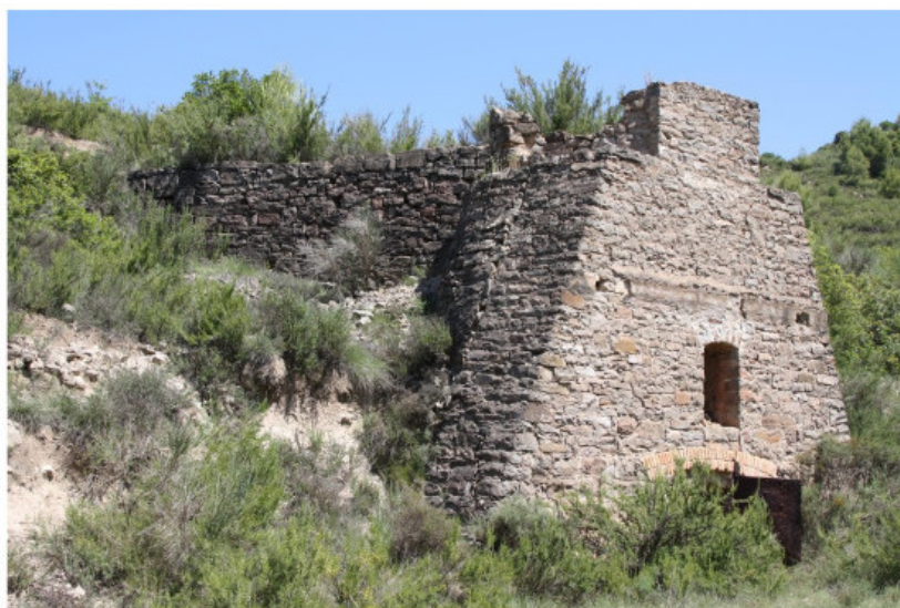
Figura 5. Súria (Forn del Torrent de Gallifa). Horno de cal de tres pisos de altura y revestimiento de ceràmica refractaria del interior del horno. Archivo Autor.
