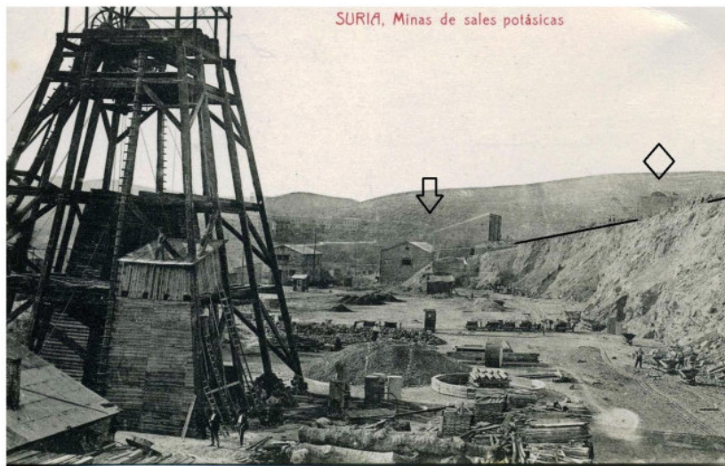
Figura 4. Súría (Fábrica de tratamiento de sales potásicas y pou “Vell” de la mina “Roumanie” durante su construcción por MINAS DE POTASA DE SURIA, S.A.). Año 1920. Autor: A.T.V. Fuente: FÀBREGA, 2009.
