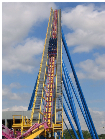
Imatge 16. Colina ascensora. Imatge extreta de: https://en.wikipedia.org/wiki/Lift_hill#/media/File:Six_Flags_Great_Adventure_-_Nitro_lifthill.jpg
